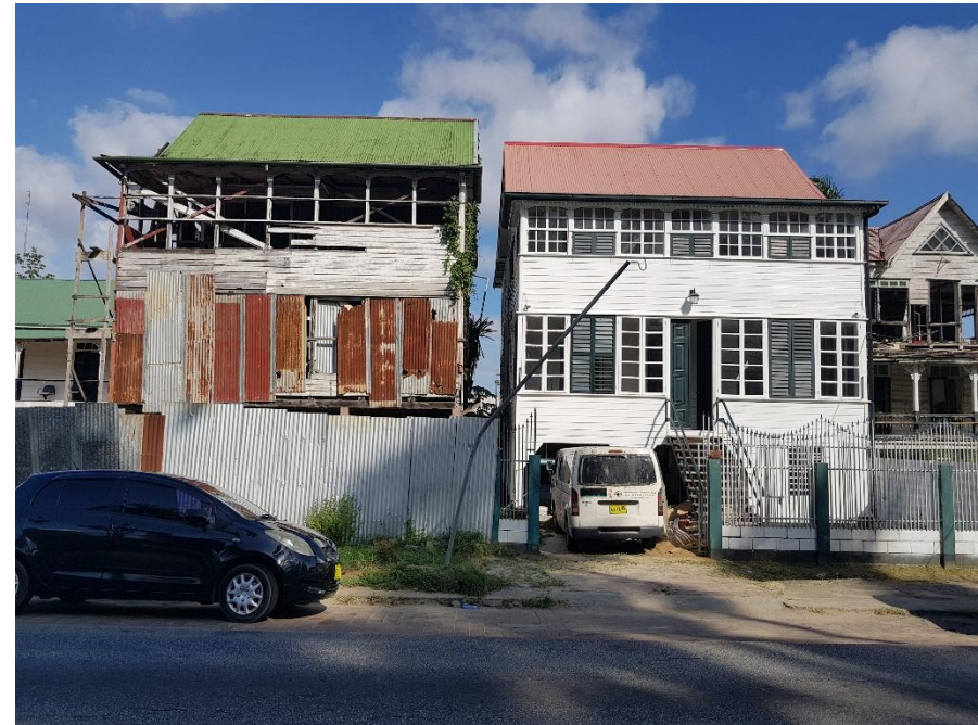
Afb. 48 – Brand is het grootste risico in de historische binnenstad. Onlangs gerestaureerde huizen naast verlaten gebouwen met een hoog risico maken het verzekeren ervan onmogelijk (Eppich, 2019)
