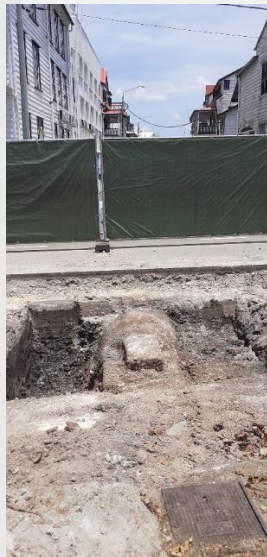
Gewelfde bakstenen riolering onder het asfalt van de Waterkant
