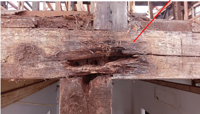
Water op gevel vanwege lekkende goot of afvoer
