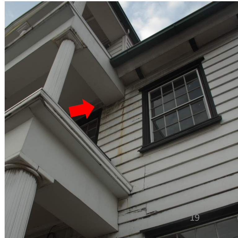
Water vanwege foute bouwkundige detaillering. Er stroomt water over de gevellijst
