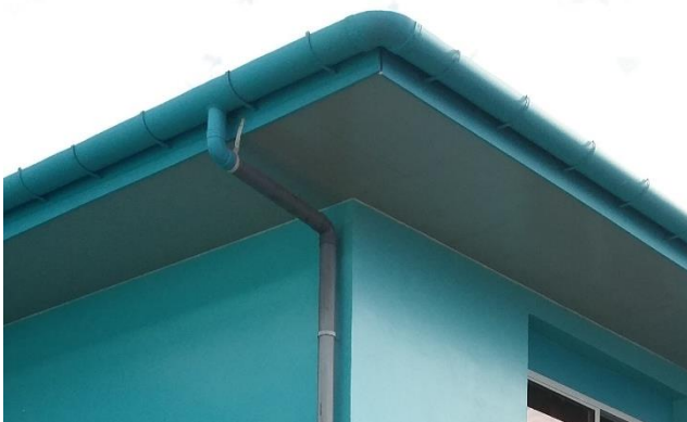
toepassing van pvc goten, beugels h.o.h. 60 cm
