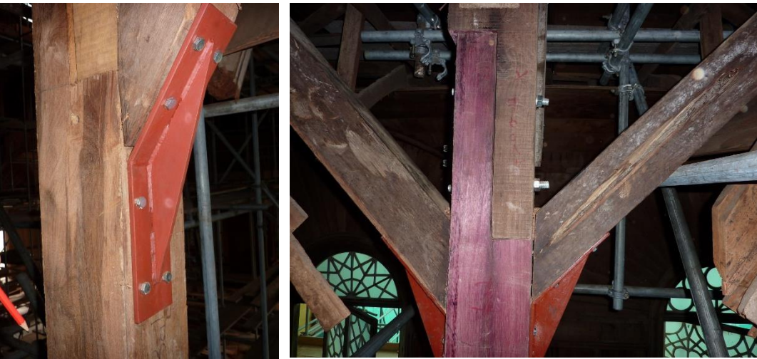
reparatieverbindingen met hoekijzers en bouten
