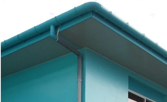
toepassing van pvc goten, beugels h.o.h. 60 cm
