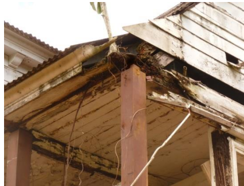
Herstel van een aangetaste dakvoet bij de DC woning te Nieuw-Amsterdam, 2014.
