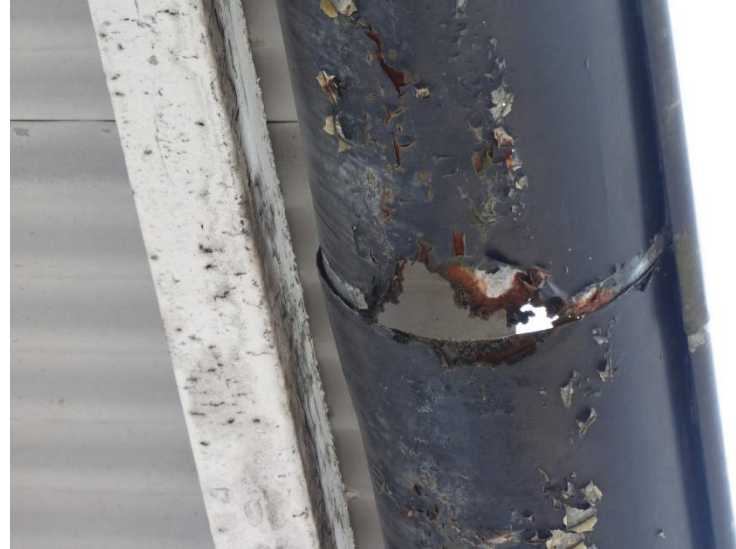
Doorgeroeste verbinding bij galvaangoot
