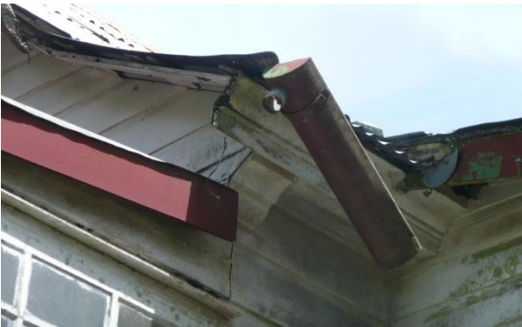
Water op gevel vanwege lekkende goot of afvoer
