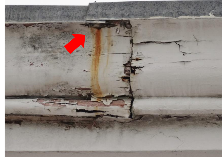
Water vanwege foute bouwkundige detaillering. Er stroomt water over de gevellijst
