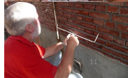
aanbrengen van knipvoeg
