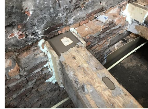
reparatie van plaatselijke aantasting met epoxy beton
