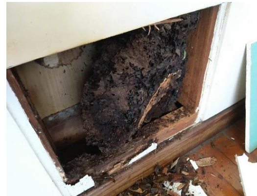
Verwijdering van een houtluizennest in een verkaste wand
