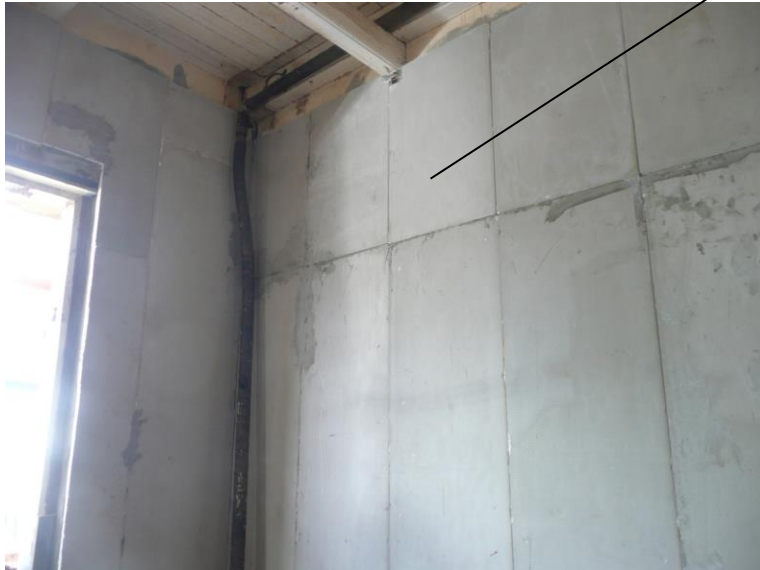
plaatsing van 3 cm multiplaat
