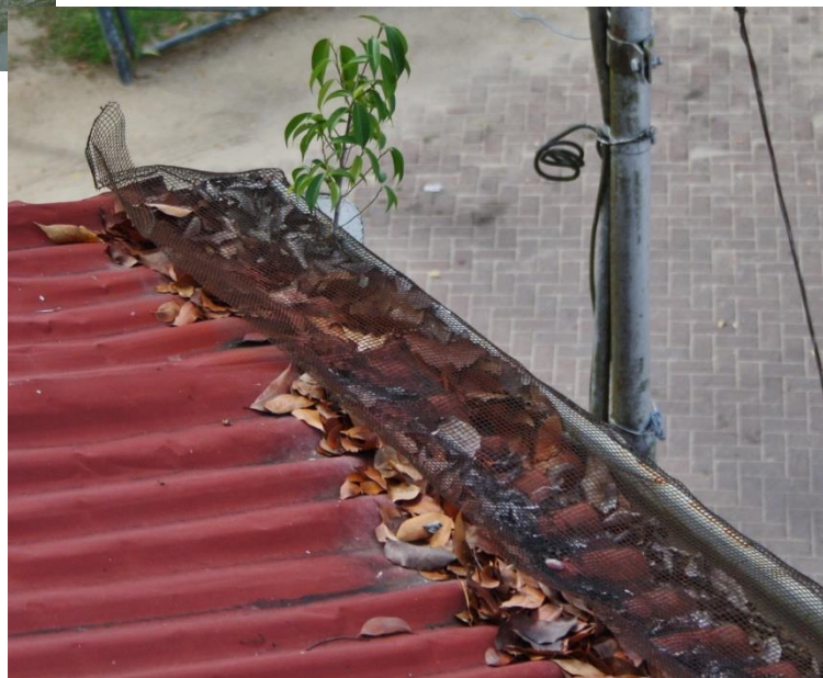
Goot met zogenaamd bladerrooster Het helpt niet Goot moet worden schoongemaakt
